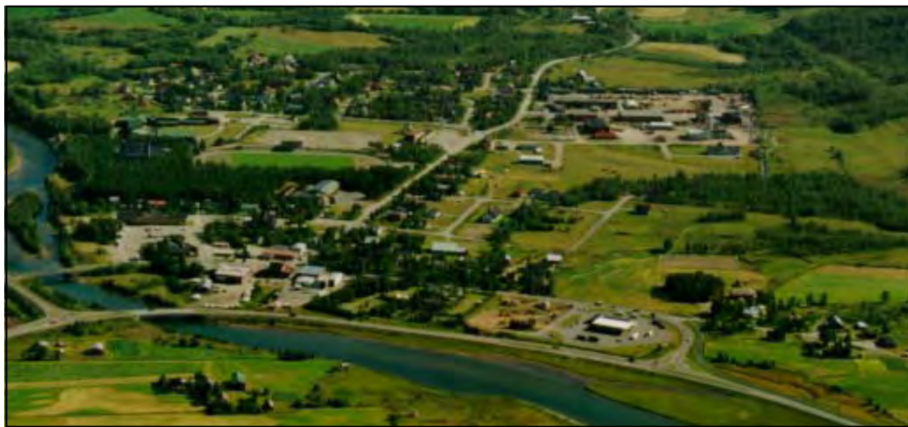
Fig. 2.1.5 Lokalsenteret Nordkjosbotn er viktig for nærmiljøet
