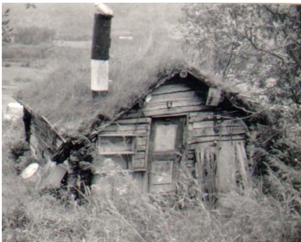
Fig. 2.2.3 En av de få verneverdige bygningene med stor verneverdi - arbeidshuset fra 1746 på gården “Bomstad”
